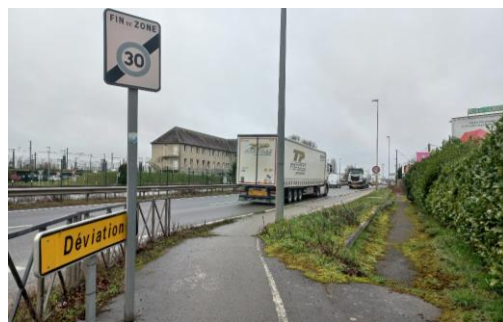
Aménagement piéton et cycliste le long de la RN10
